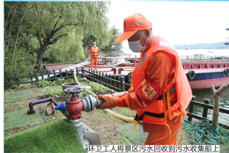
环卫工人将景区污水回收到污水收集船上
