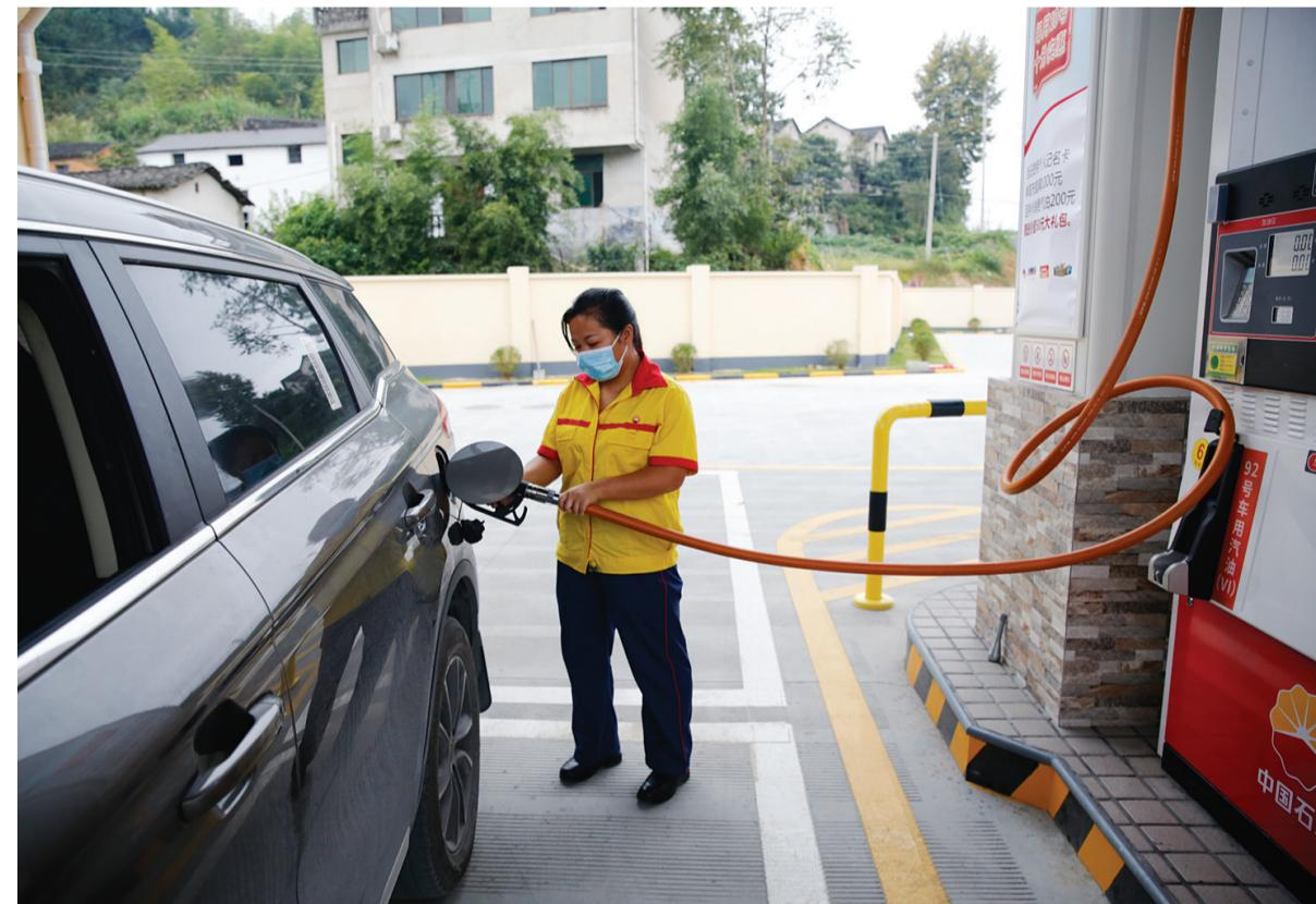
9月3日,威坪镇屏村加油站正式投入使用。屏村加油站坐落于威坪镇屏村村北侧地块,总建筑面积325.5平方米。共设置了5只30立方米埋地油罐、4台双油品2枪加油机,可加注95号、92号汽油、柴油。
