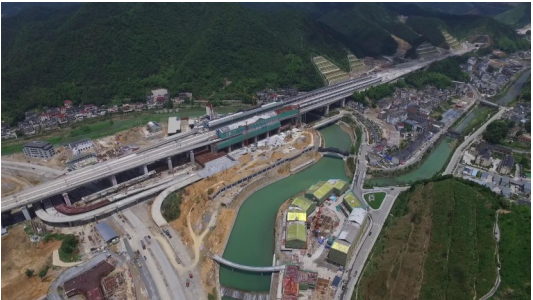
正在施工中的高铁千岛湖站
