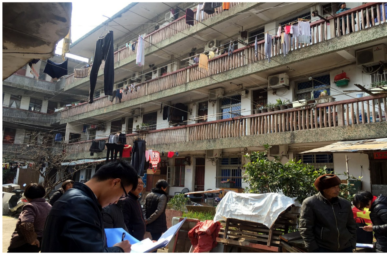
城镇危旧房排查
