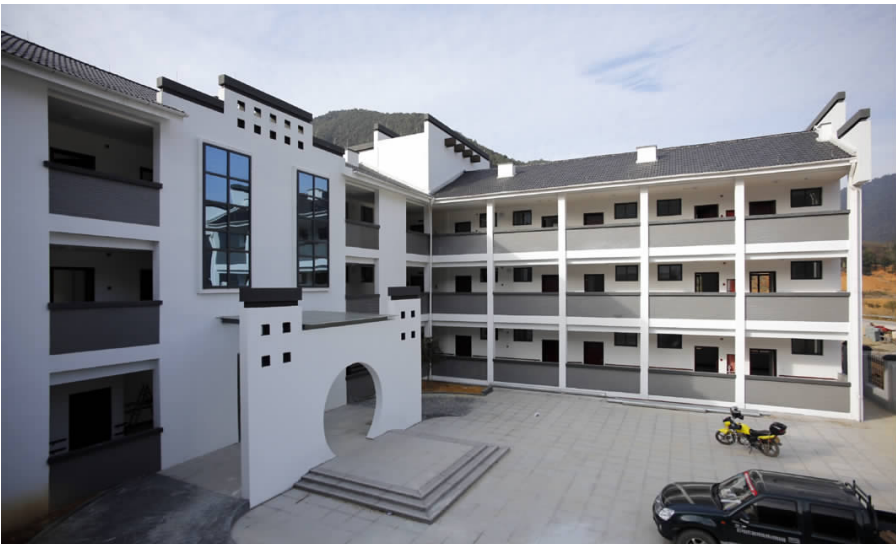
12月21日,里商乡里阳村已经完工的养老服务中心楼宇
