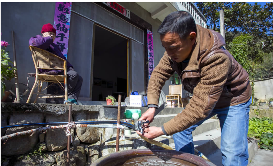
12月22日,宋村乡白云溪村,施工人员在村民家中安装自来水管
