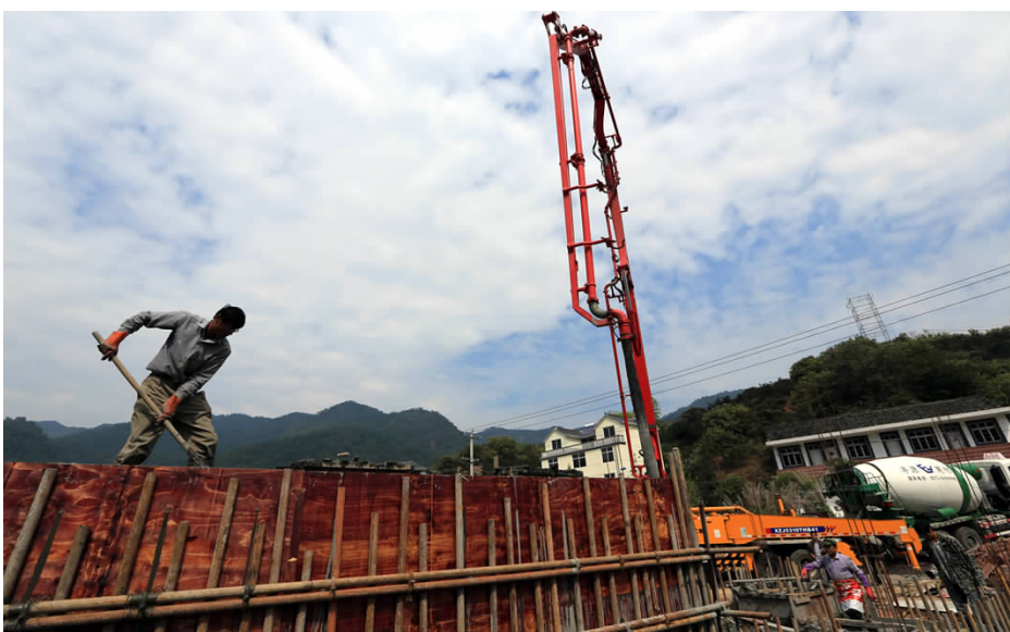
10月17日,界首乡桐子坞村截污纳管工程在施工中
